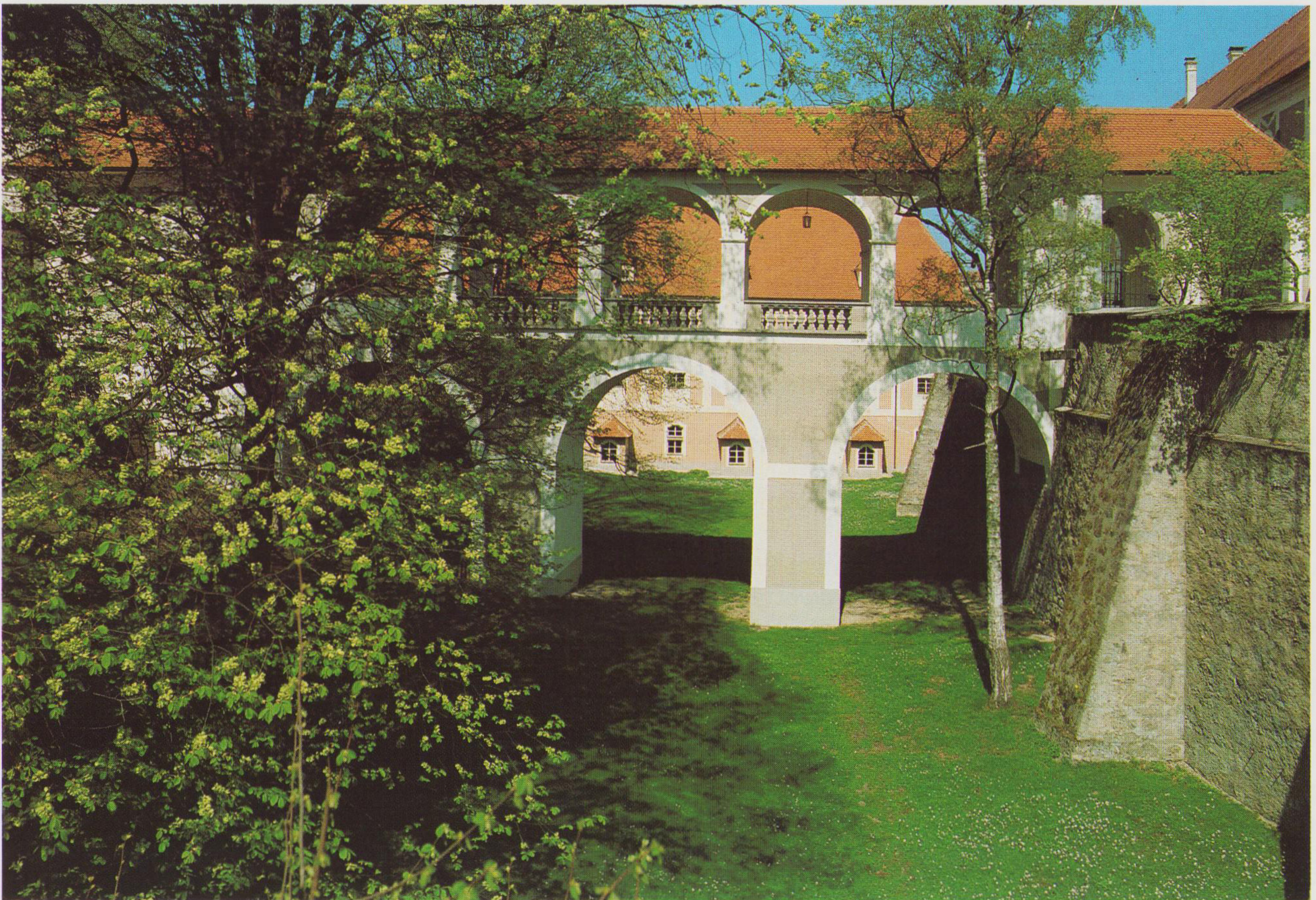
Arkadengang der Brücke über den Burggraben des Schlosses Lamberg
