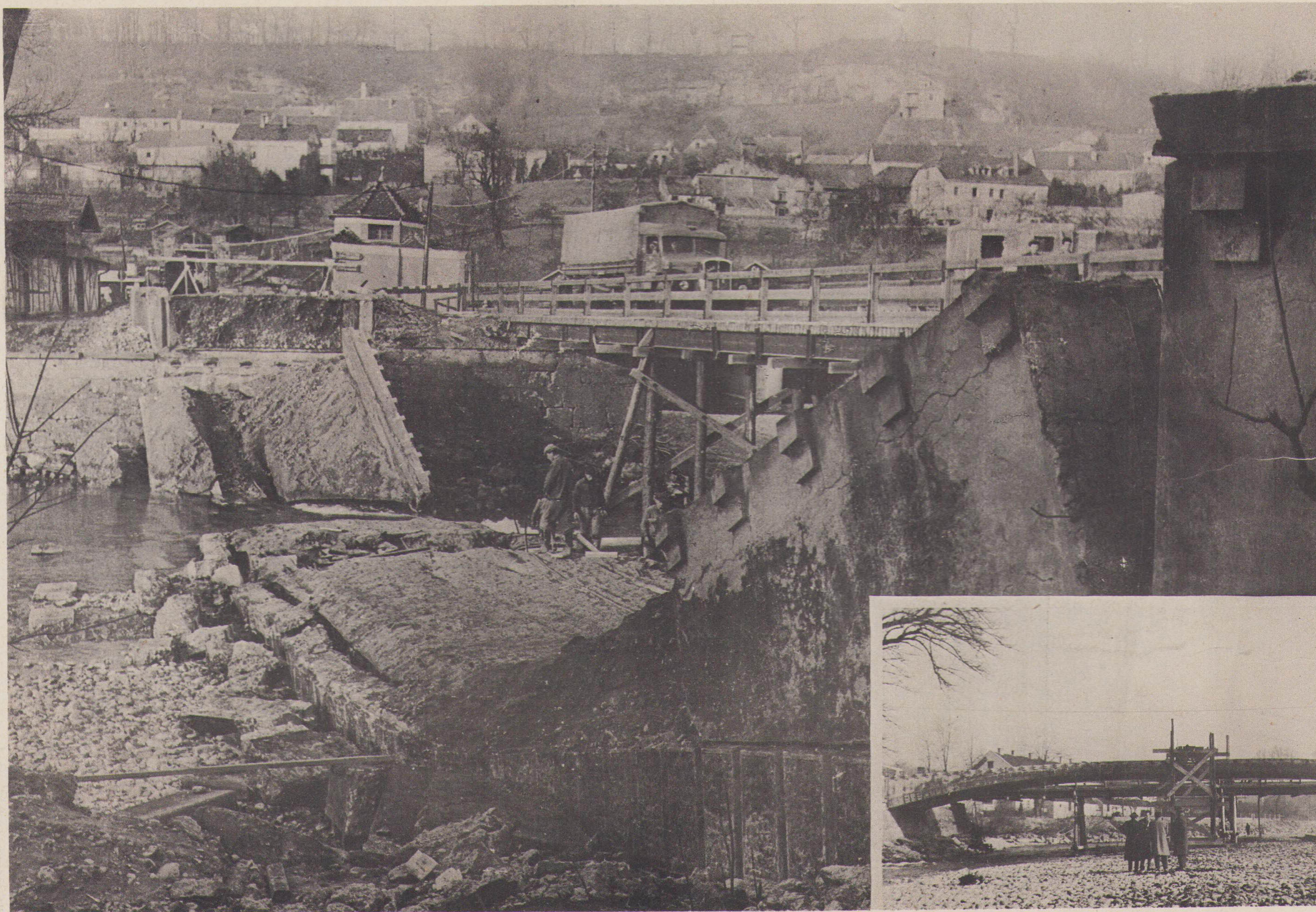
DAS ENDE DER ALTEN SCHWIMMSCHULBRÜCKE AM 19. 11. 1959 - NACHDEM VON EINEM HILFSGERÜST AUS DIE KONSTRUKTION IN DER MITTE DURCHTRENNT WURDE, STÜRZTEN DIE BEIDEN BRÜCKENHÄLFTEN UM 19, 45 UHR IN DAS MITTERWASSER DER STEYR; RECHTS UNTEN NOCH EINMAL DIE ALTE SCHWIMMSCHULBRÜCKE KNAPP VOR IHREM EINSTURZ
