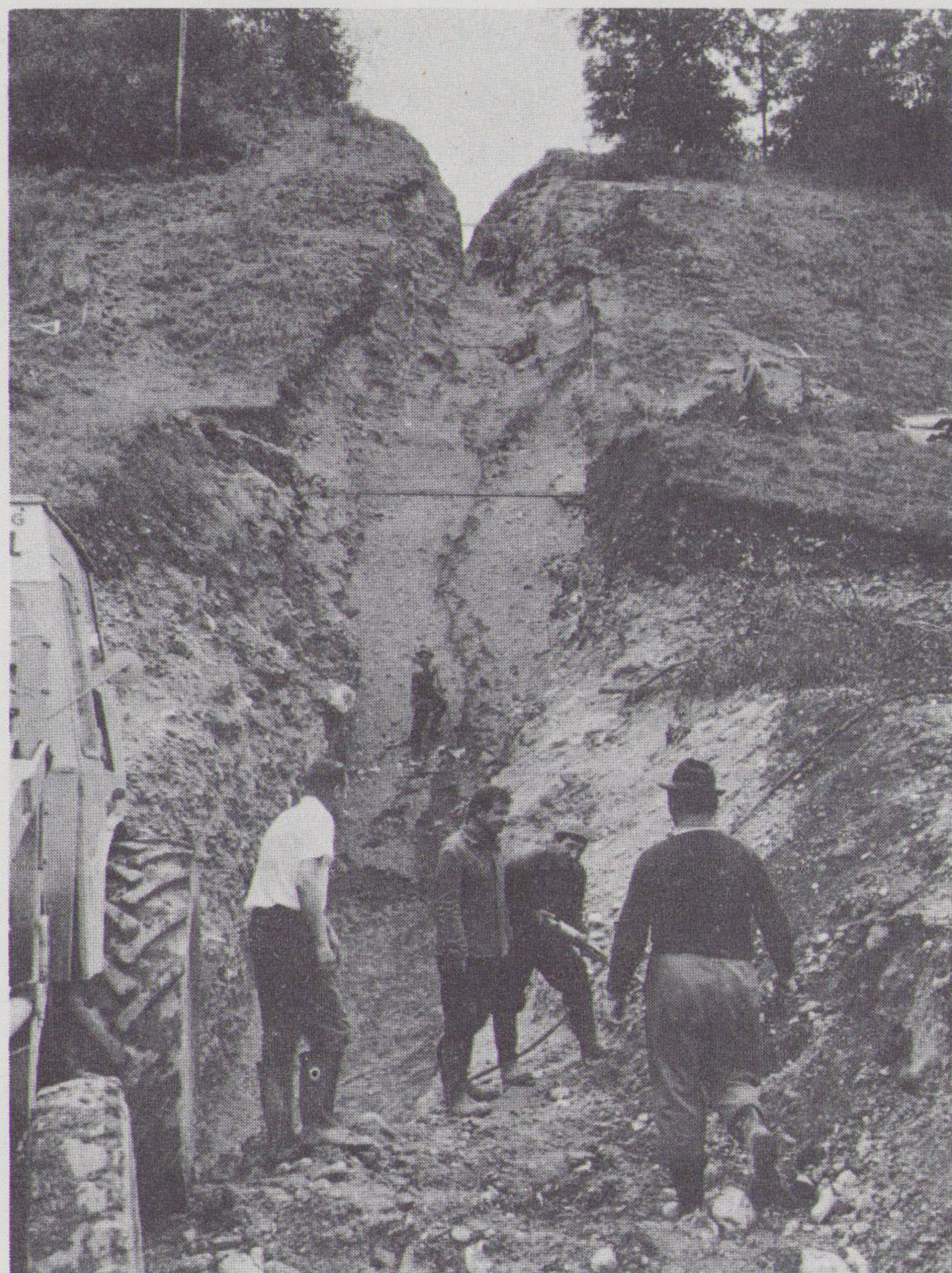
FÜR DEN SAMMELKANAL "F" SIND GROSSE ERDBEWEGUNGEN ERFORDERLICH. IM BILD DIE KANALVERLEGGUNG ÜBER DEN STEILABFALL ZUR ENNS BEIM GASTHAUS SANDMAYR
