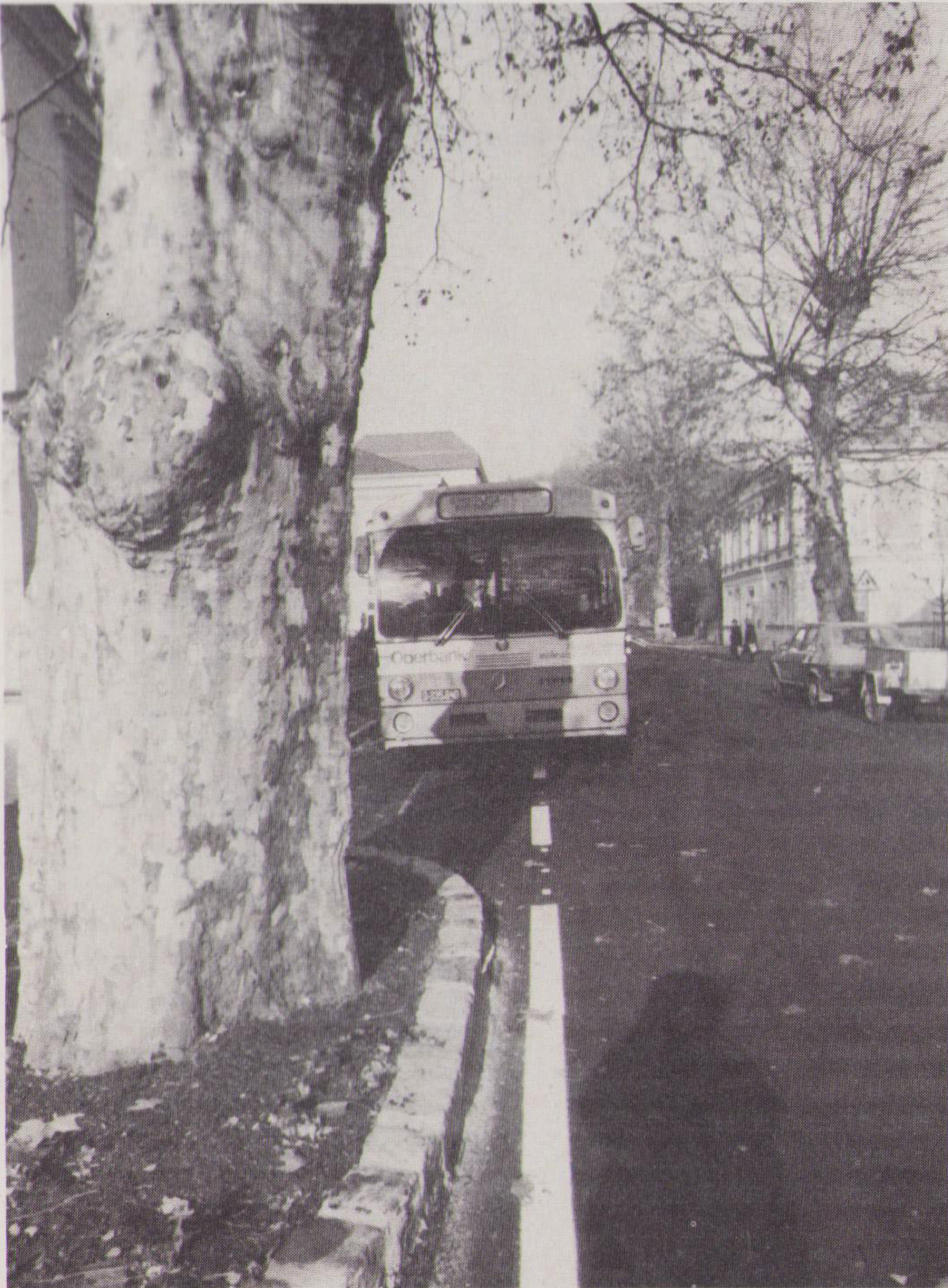
Im Zuge der Sanierung der Schwimmschulstraße wurden die Busbuchten den Anforderungen entsprechend ausgebaut. – Zwischen Fahrbahn und Gehsteig wurden entlang der Platanen-Allee Grünstreifen angelegt. Dieser Streifen war früher asphaltiert. Nun kommt das Regenwasser besser zu den Wurzeln der Bäume, die außerdem auch noch mit Langzeitdünger genährt wurden, so daß alle Voraussetzungen gegeben sind, daß die alten Bäume noch lange gedeihen.
