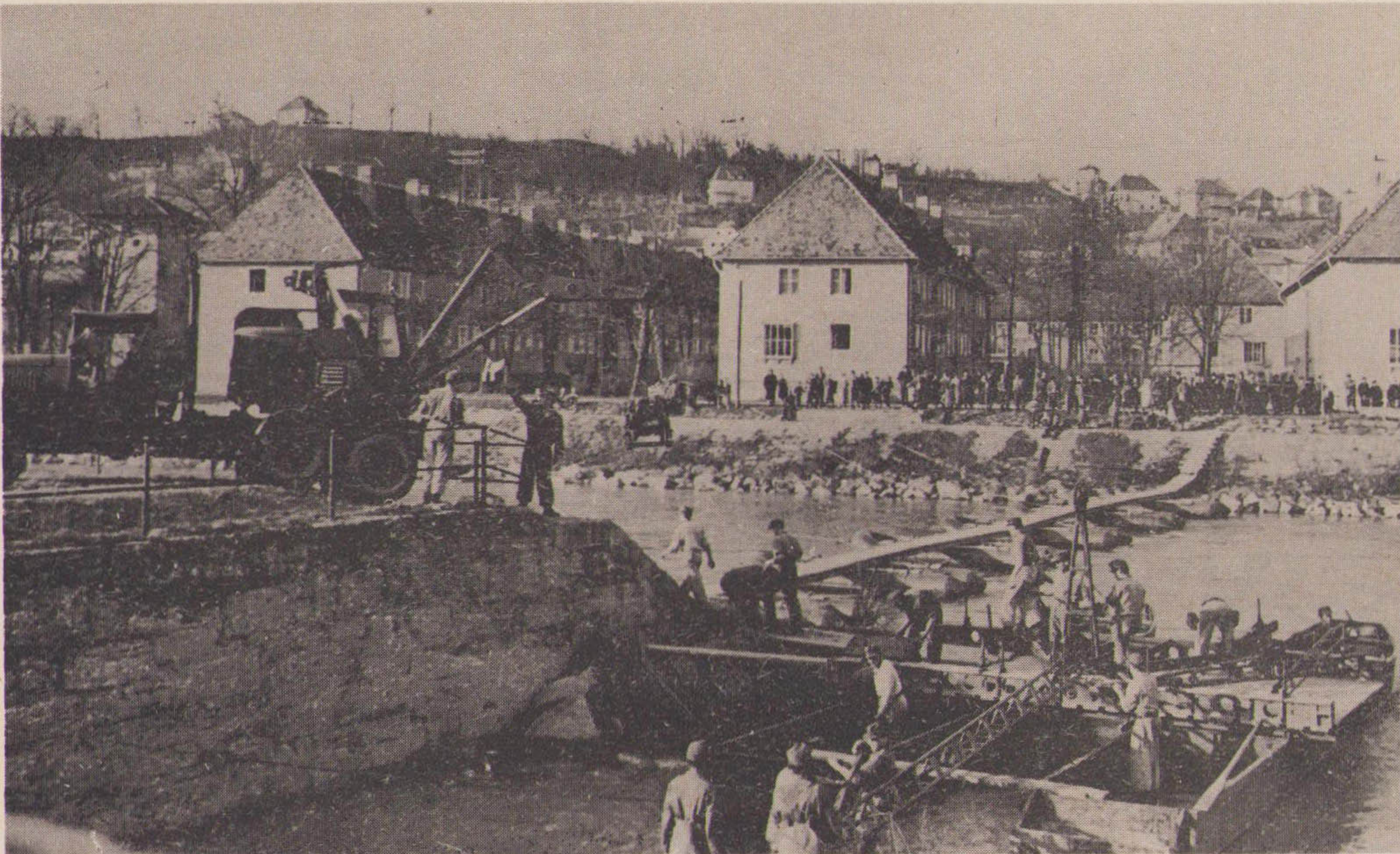
Die Dieselramme zum Schlagen der Piloten wird auf Ponton's aufgebaut - im Hintergrund der Behelfssteg.
