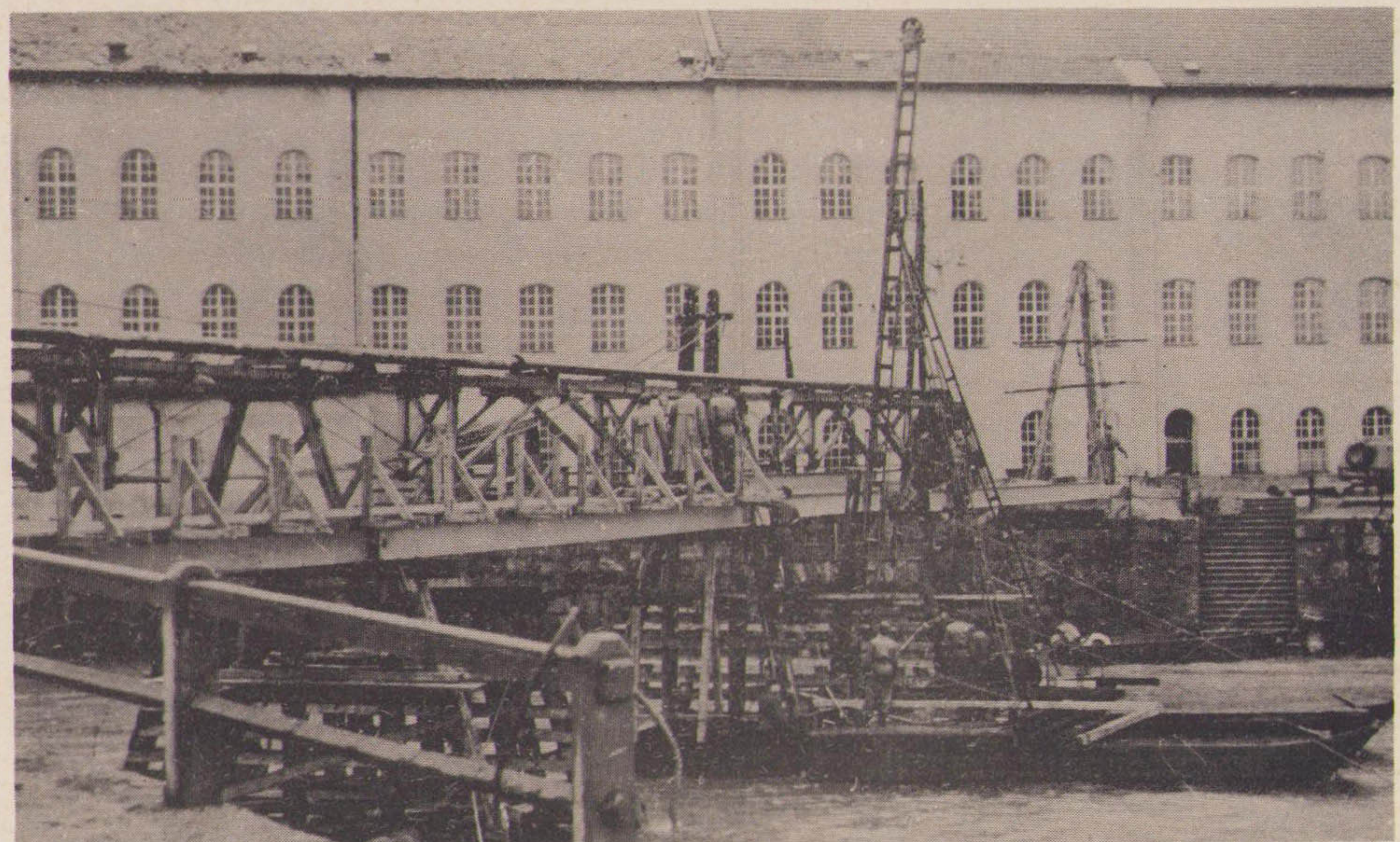
Die Dieselramme zum Schlagen der Piloten wird auf Ponton's aufgebaut - im Hintergrund der Behelfssteg.
