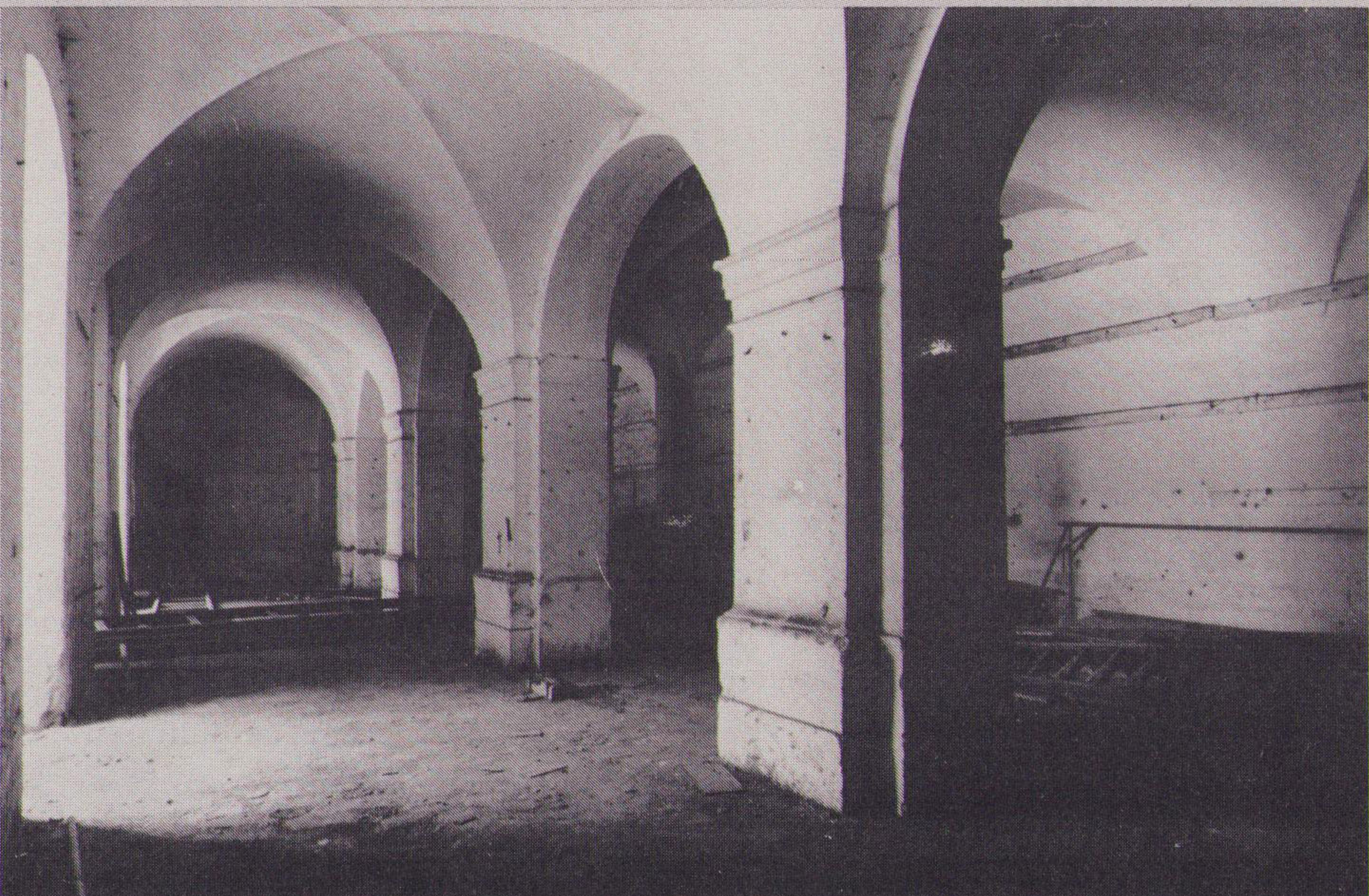
Das Erdgeschoß (Bild unten) ist mit seinen Kreuzgewölben besonders qualitativ. Diese 23×13 Meter große Halle soll für wechselnde Ausstellungen und Veranstaltungen genutzt werden.
