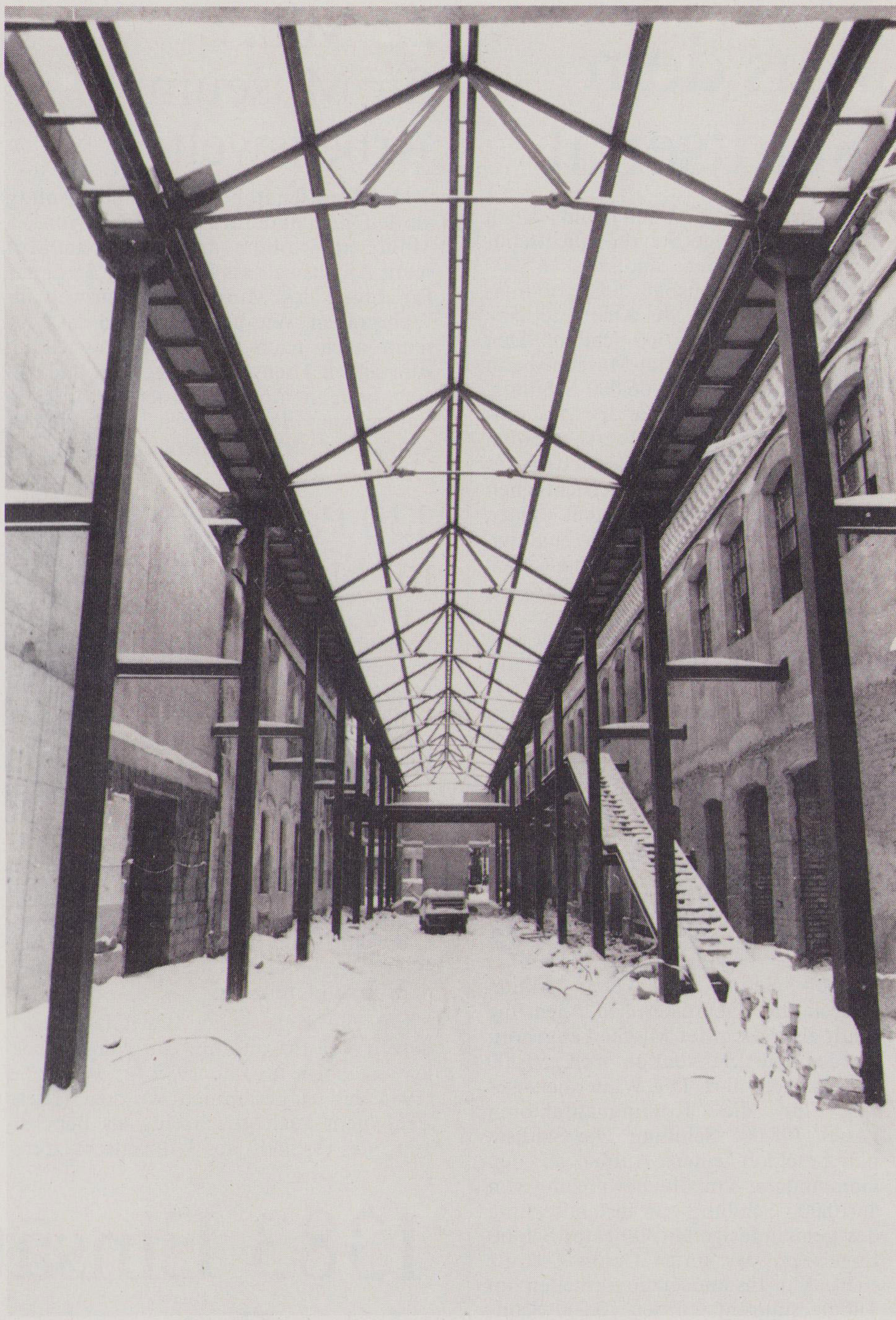
Zwischen den beiden Trakten werden unter dieser Stahlkonstruktion, die noch mit Glas verkleidet werden wird, die Leitexponate der Ausstellung präsentiert: Wasserrad, Dampfmaschine, E-Werk und Computer.
